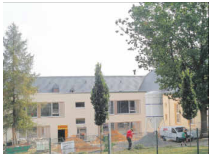
Die Gerüste sind gefallen 14.08.2020
