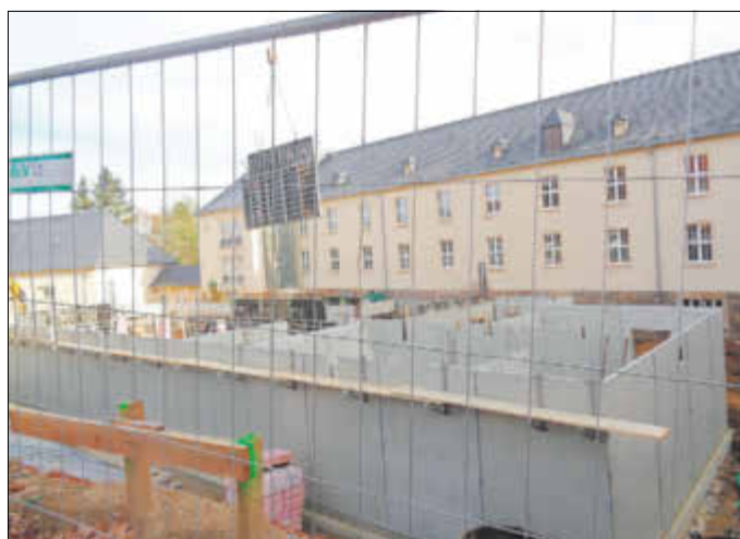
Fundament mit Verschalung 26.10.2019
