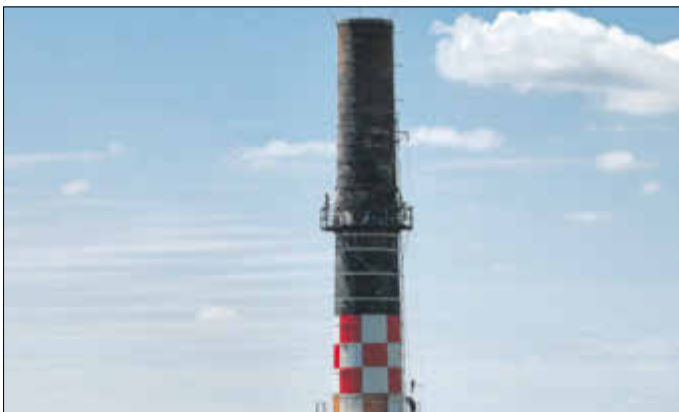
Instandsetzungsarbeiten an der Hohen Esse | © Dresdner S+F Bau GmbH
