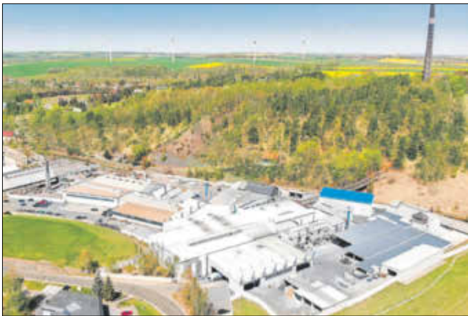
Luftbildaufnahme Feinhütte Halsbrücke GmbH mit „Hoher Esse“ | © Feinhütte Halsbrücke GmbH
